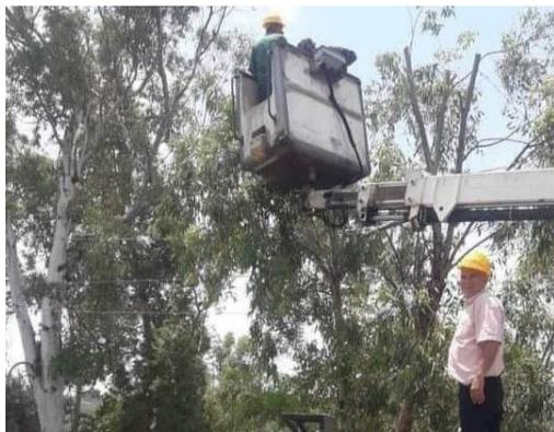
ضمن الخطة الاستثمارية لمديرية الكهرباء في طرطوس ومناطقها، ويهدف تحسين واقع الشبكة الكهربائية، ومعالجة ضعف التيار الكهربائي قامت ورشة الطوارئ في صافيتا بإبدال مسافات منخفضة على محولة بعمره - المدرسة كما قامت بإجراء صيانة على خط توتر بعمره، حيث تم إبدال جسور توتر، ومتابعة قص الأشجار المتداخلة مع خطوط التوتر على خط توتر السد، والعمل على إجراء صيانة على تابلو محولة بيت دقيق، حيث تم إبدال قواعد فواصل كما تم نقل شبكة توتر متوسط من بورتيك خشبي مائل إلى برج جديد
